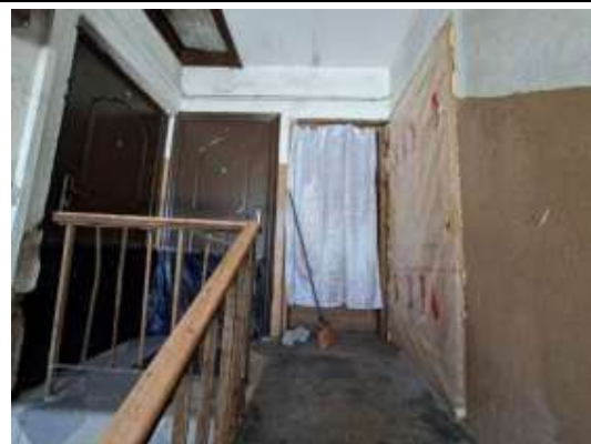
2.stāva kāpņu telpa
