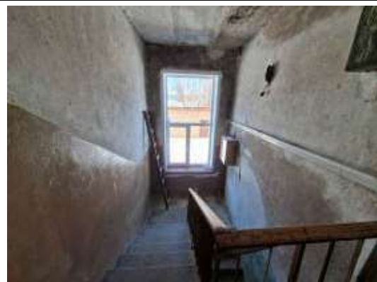
2.stāva kāpņu telpa
